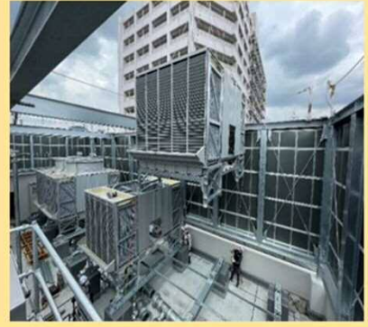
エネルギー棟 設備類の搬入
