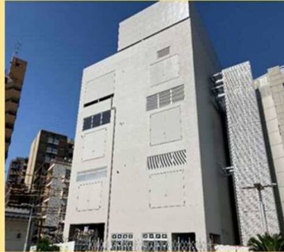
エネルギー棟
