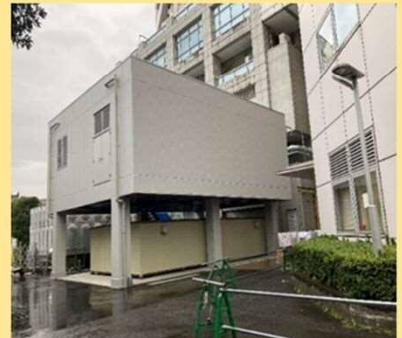
給水ポンプ棟
